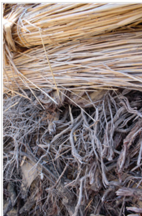
5-ші сурет. Қабырғасы көкбұта, үсті камыс шеген. Арал, Шижаға, иесі Қайыпұлы Мақсұт
