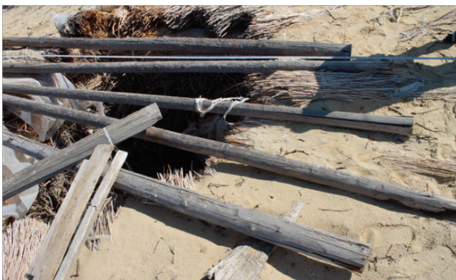
4-ші сурет. Астыңғы бөлігі дүзген, жоғарғы қабырғасы көкбұта, үсті қамыспен шегенделген құдық. Арал, Шижаға, иесі Қайыпұлы Мақсұт
