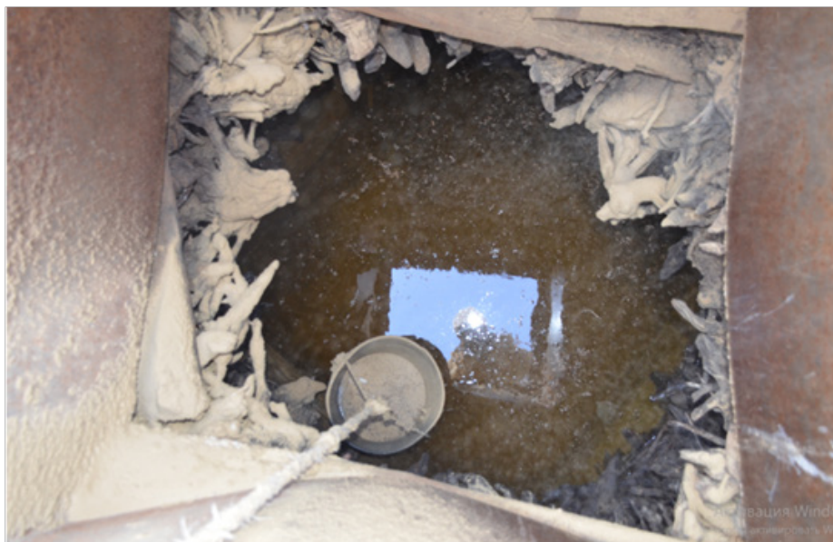
9-ші сурет. Өте таяз көкбұтамен шегенделген ілме құдық. Арал, Тапа
