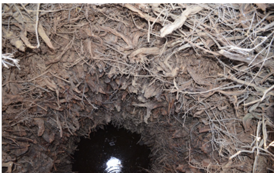
7-ші сурет. Көкбұта шегеннің қабырғасы мен түбі. Арал, Сазды. Иесі Баетов Ұнатхан
