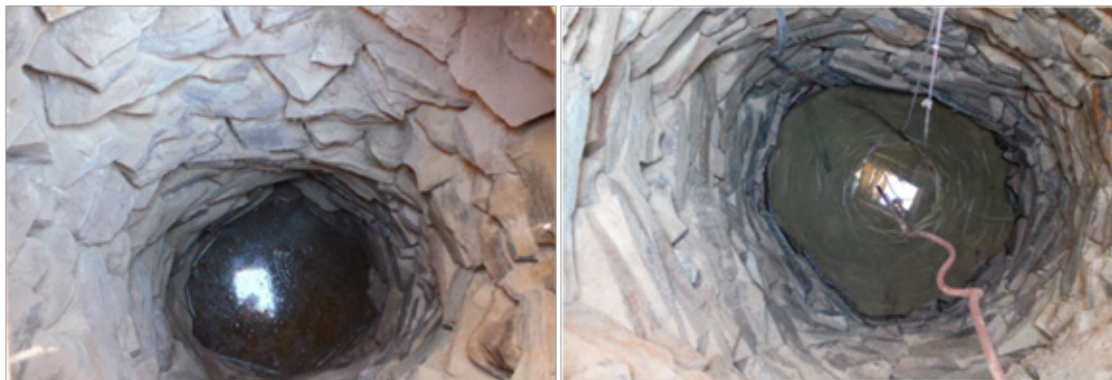
15-ші сурет. Тас шеген. Арал, Жалаңаш
