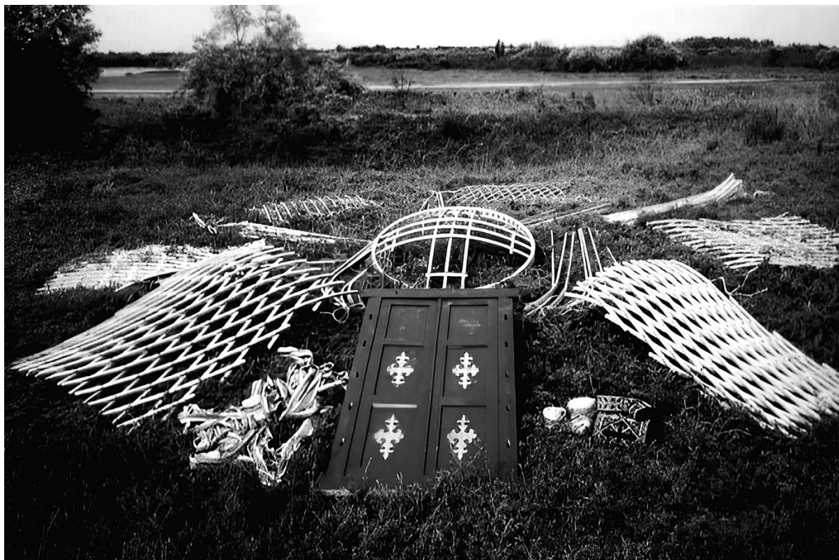
4-сур. Киіз үйдің құрылымдық бөліктері. (Қазақстан Архитектурасы. 8 том. 2012. 35 б.).
